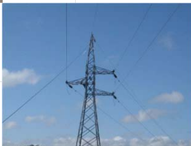
Tendido de OPGW
