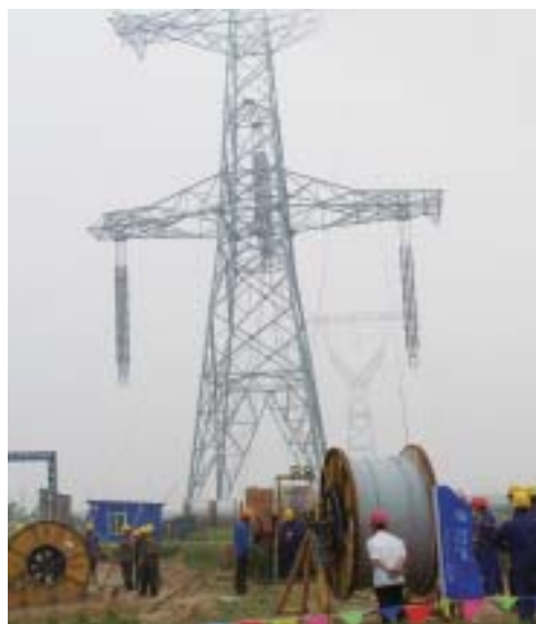
Tendido de cable OPGW
