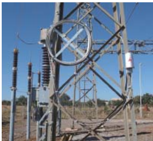
Instalación de mufa
