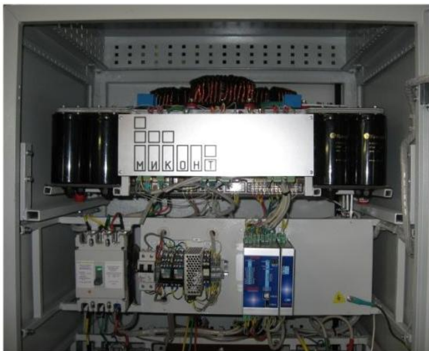
Рис.3 Силовой блок АПЧ-ТТП
